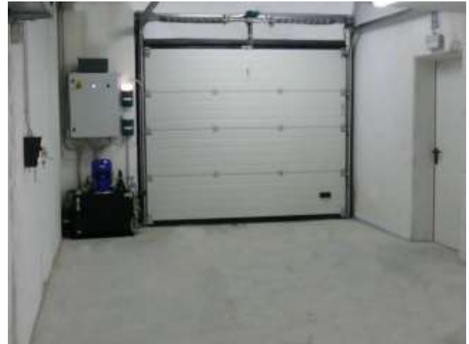
Applicazione portone sezionale al piano interrato
